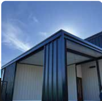
Casa hecha con paneles Mega Lite
