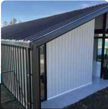
Casa hecha con paneles Mega Pro
